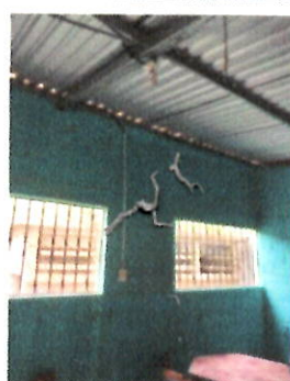
REPARACION SISTEMA ELECTRICO CAMBIO DE LUMINARIAS, APAGADORES, TOMACORRIENTES, CABLEADO Y DUCTO
