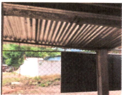
CUBIERTA DE LAMINA, SUSTITUCION DE CUBIERTA DE LAMINA EN MAL ESTADO
