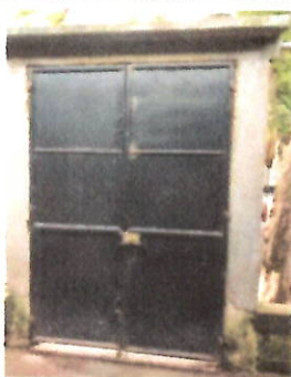
MANTENIMIENTO A PORTON, CAMBIO DE CHAPA Y PINTURA
