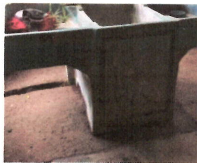
SUSTITUCION DE PILA EN MAL ESTADO
